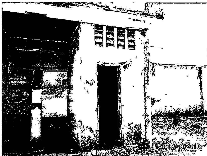
FIGURA 7 - ENTRADA E WC.
