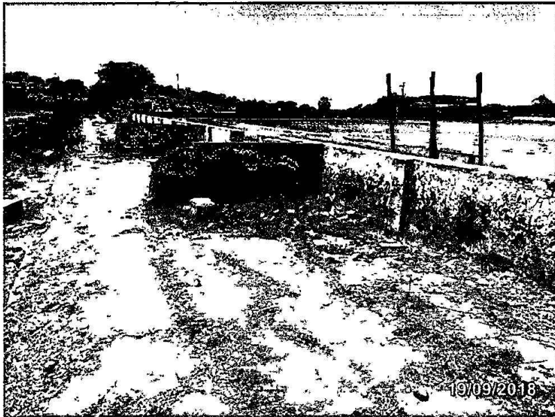
FIGURA 17 - MURETA DO CAMPO
