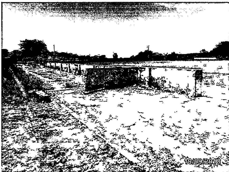
FIGURA 14 - MURETA DO CAMPO
