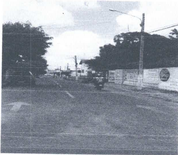
Foto 01 – Início da Obra da Pavimentação em Avenida Márcio Nogueira em Iguatu-Ce
