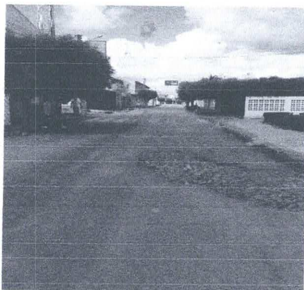
Foto 03 – Pavimentação em Pedra Tosca da Av. Márcio Nogueira em Iguatu-Ce.
