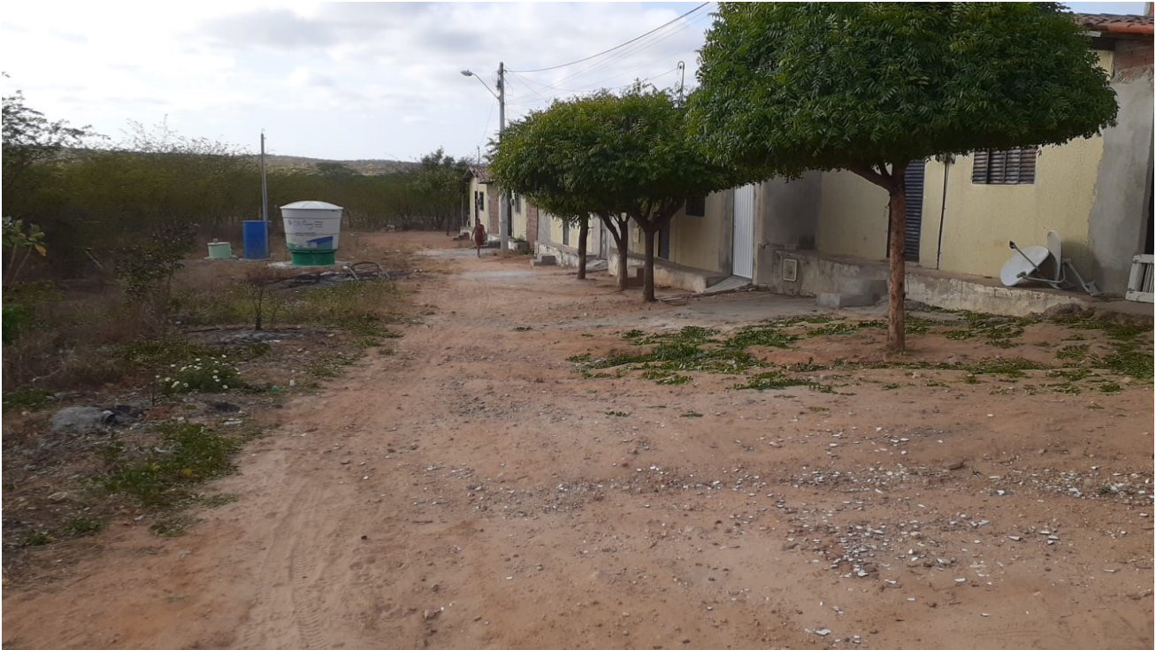
Foto 02 – Detalhe de Calçadas, Rampas, Degraus e Poste à Direita e Reservatório à Esquerda.
