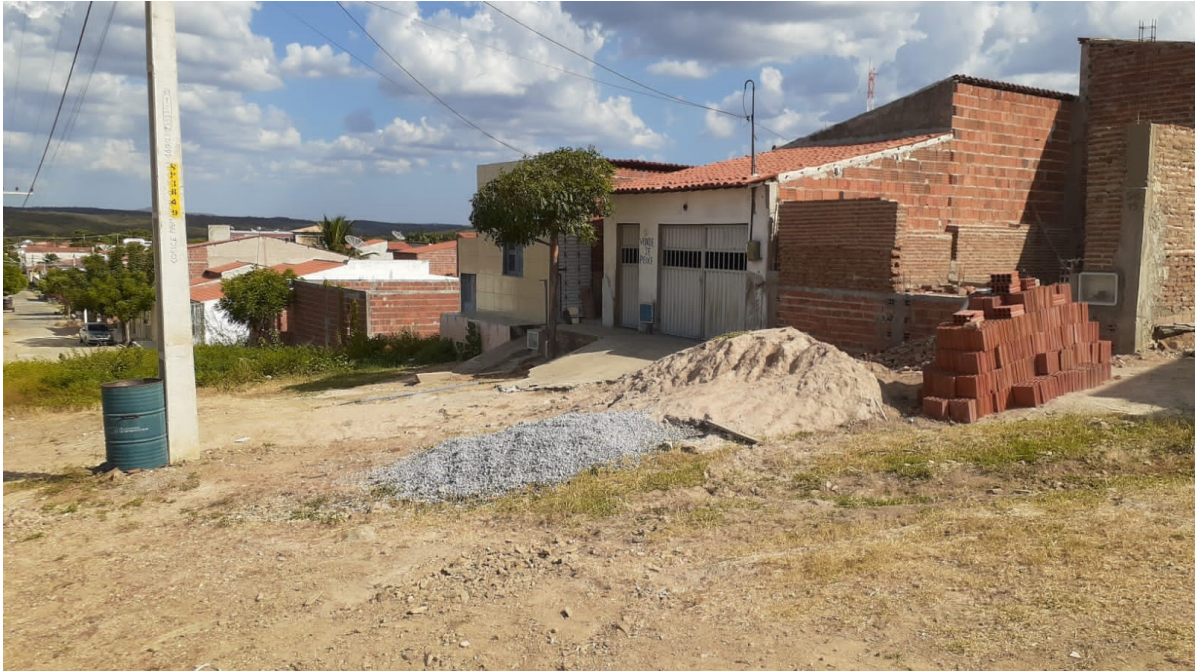
Foto 21 – Evidências de Calçadas, Rampas, Degraus e Árvore de um lado e Poste do outro lado.
