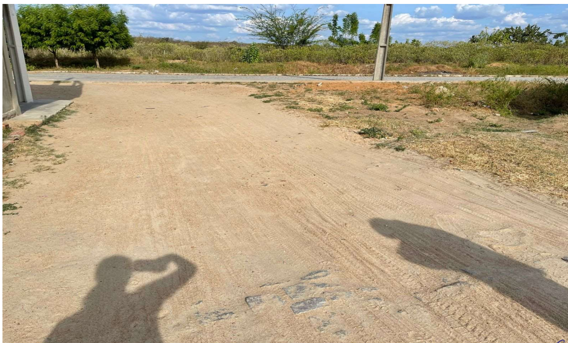
Foto 07 – Evidências de Calçada Estreita e Postes em um dos lados.
