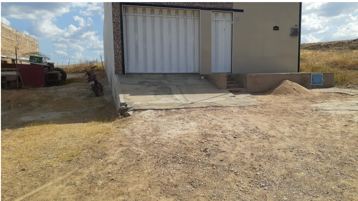
Foto 22 – Detalhe de Calçadas, Degraus, Rampas.
