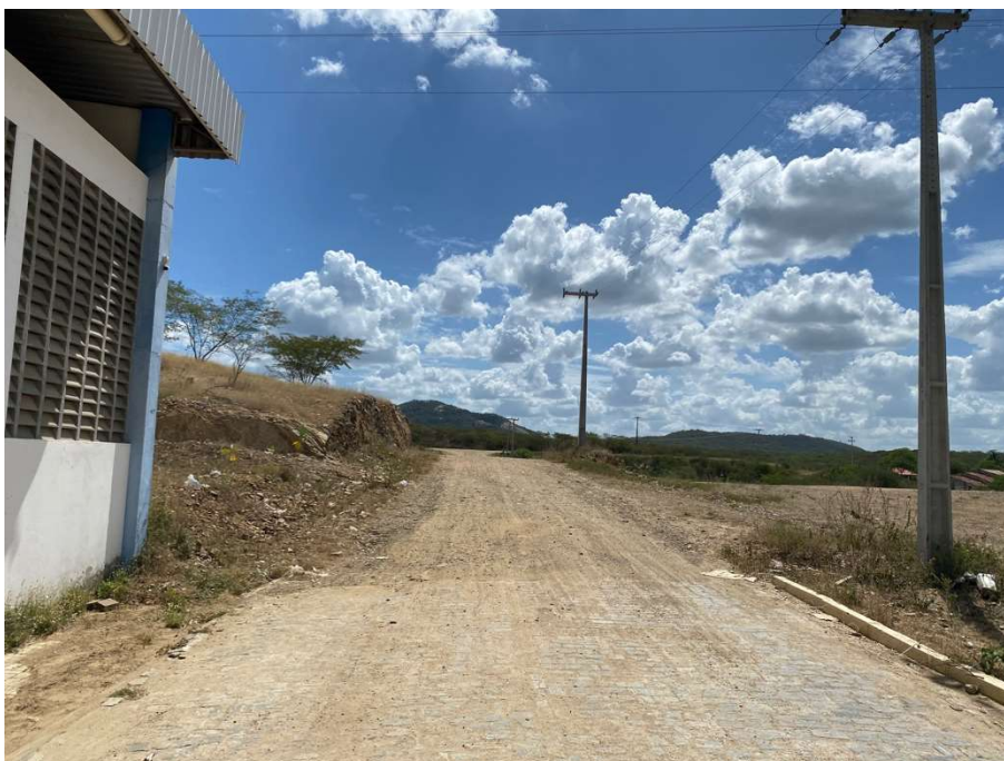
Figura 2 – FINAL DA AV. PROJETADA – TRECHO 01
