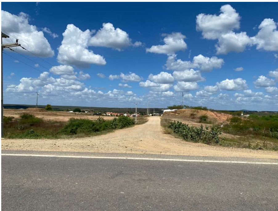
Figura 1 – INÍCIO DA AV. PROJETADA – TRECHO 01
