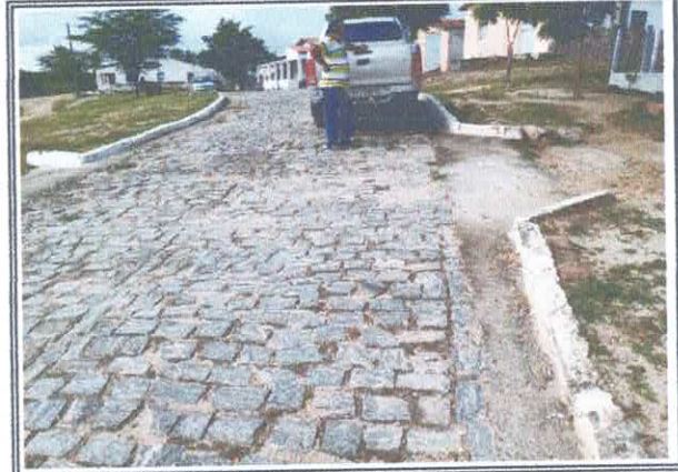
RUA DE ACESSO
