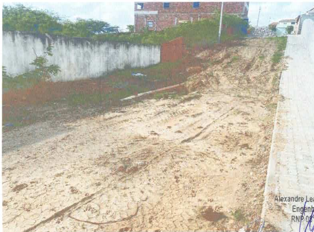
Figura 4 – TUBO, CAIXA DE DRENAGEM E CALÇADA EXISTENTES
