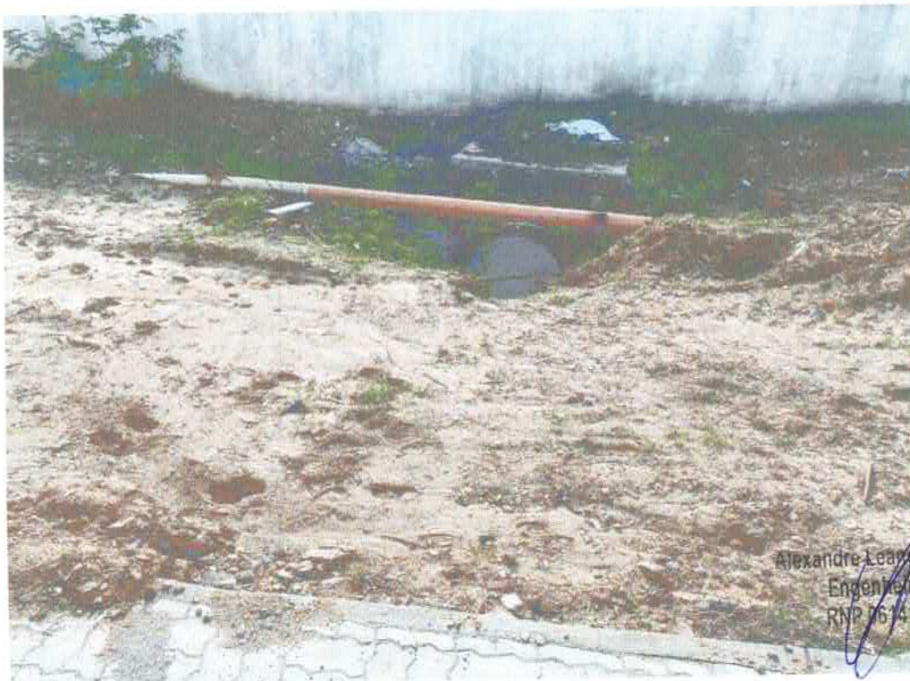
Figura 2 – TUBO E CAIXA DE DRENAGEM EXISTENTES
