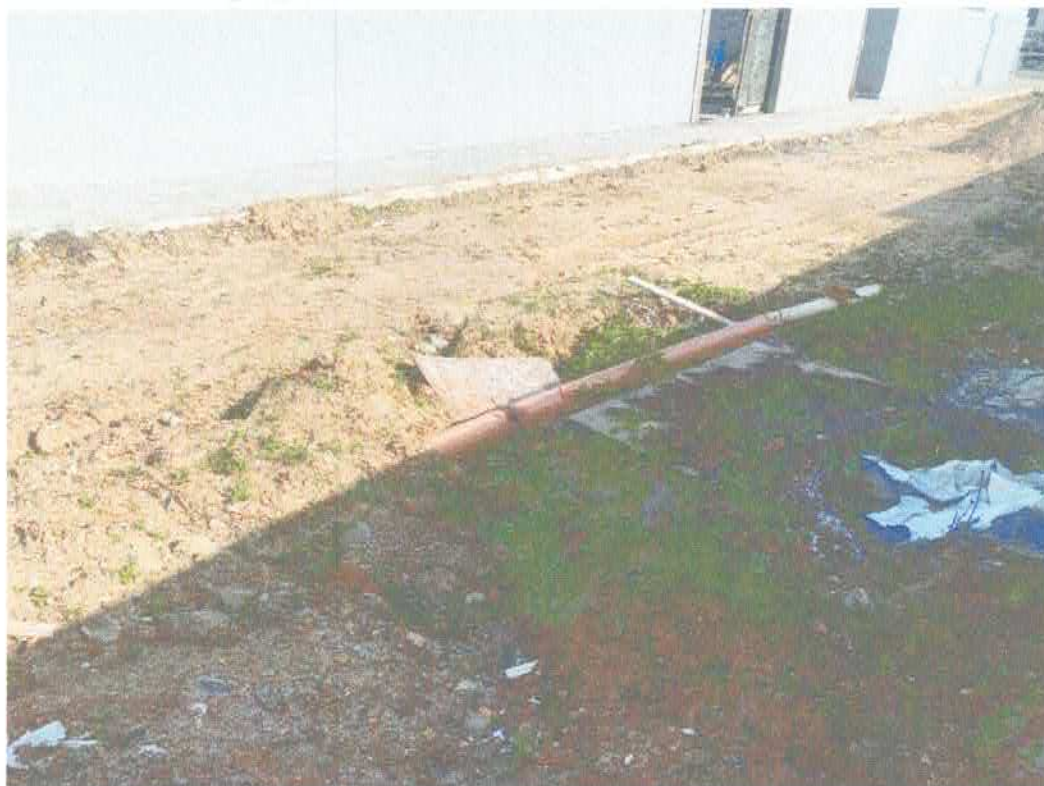
Figura 3 – TUBO, CAIXA DE DRENAGEM E CALÇADA EXISTENTES
