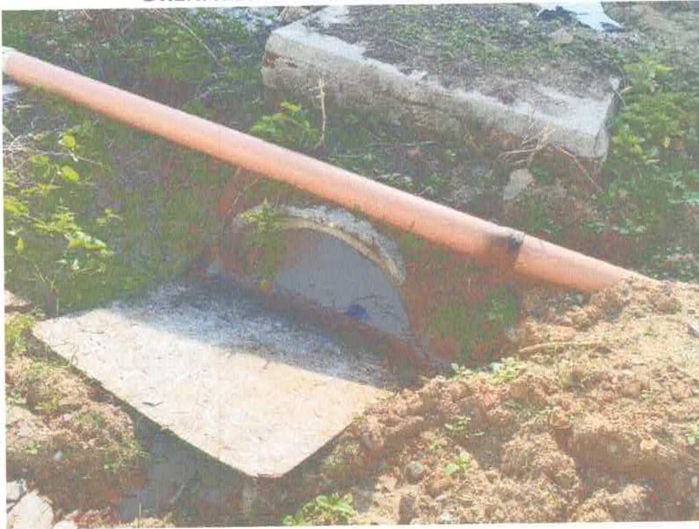
Figura 1 – TUBO E CAIXA DE DRENAGEM EXISTENTES
