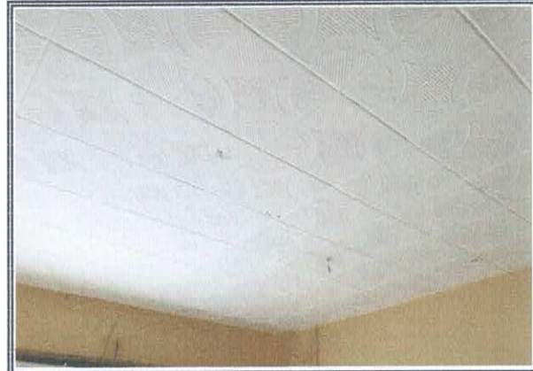
FORRO DE GESSO
