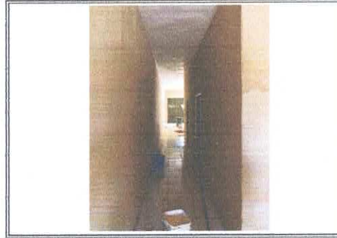
ACESSO A SALAS (CORREDOR)
