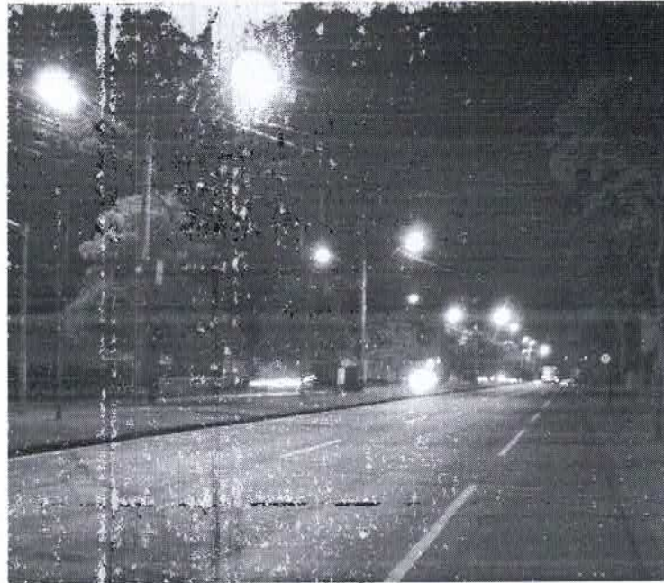
Figura 21 – Via coletora com cabeleira central iluminada com luminárias integradas e lâmpadas a vapor de sódio
