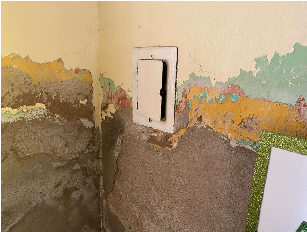
Figura 22 – QUADRO DE ENERGIA
