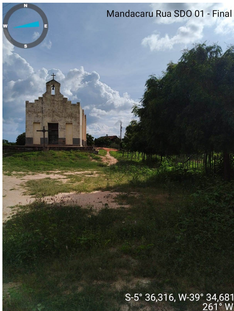
Foto 04 – Final: Evidências de Árvores, Cercas e Postes Existente.
