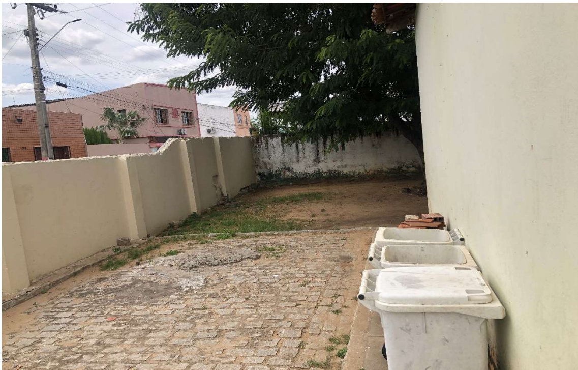
Figura 14 – LOCAL DE FECHAMENTO C/ALVENARIA E PORTÃO DE FERRO
