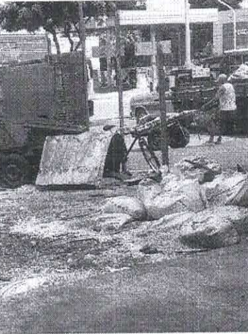
Conforme a Prefeitura, a empresa responsável pela obra não conseguiu cumprir o contrato
