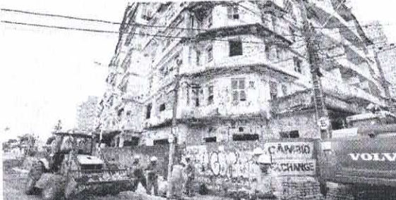
A demolição do prédio acontecerá de cima para baixo e custará cerca de R$ 1,7 milhão
