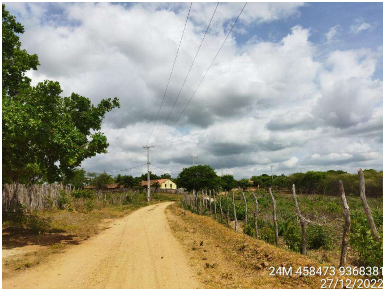
Foto 01: Início do Trecho
