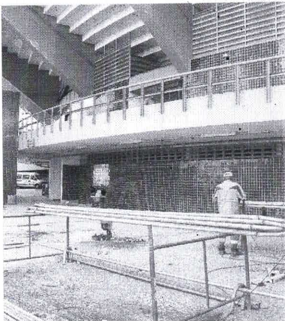
As obras de infraestrutura que estão sendo realizadas foram orçadas em R$ 5,5 milhões
