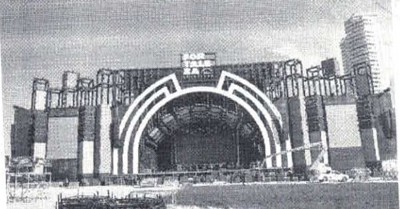
O palco de 74 metros de largura e 22 metros de altura começou a ser montado no início de dezembro
