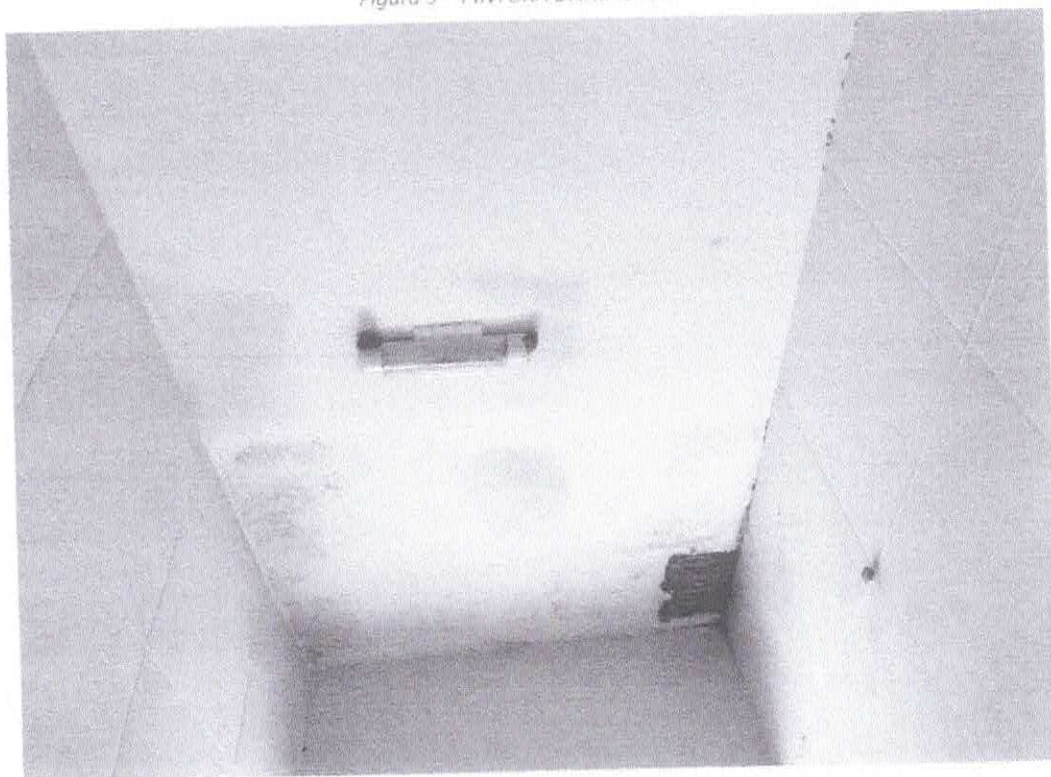
Figura 6 - PINTURA DANIFICADA
