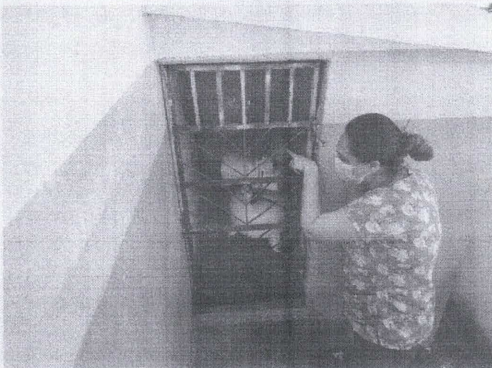
Figura 6 – INSTALAÇÃO EXPOSTA COMPRESSOR
