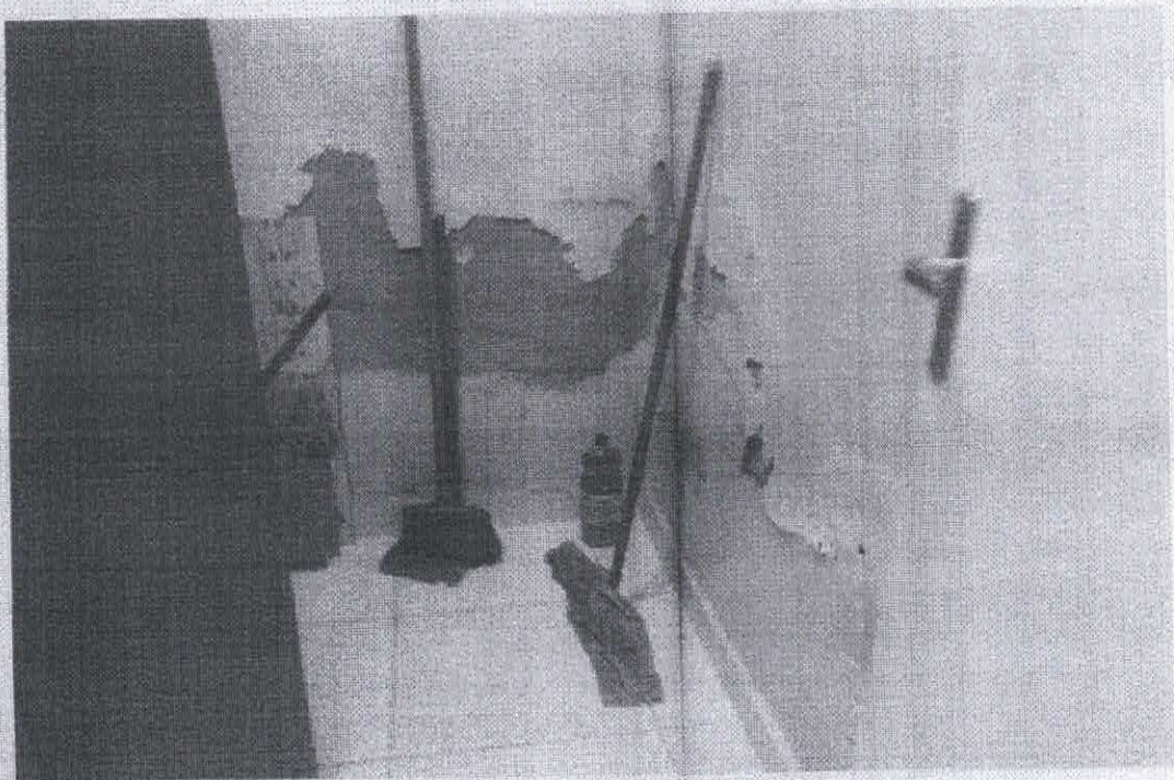
Figura 8 - REVESTIMENTO DANIFICADO
