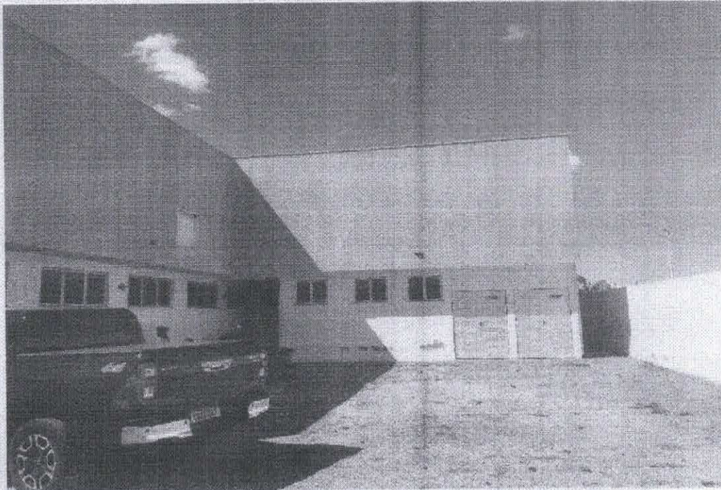
Figura 3 – FACHADA – LATERAL / FUNDOS
