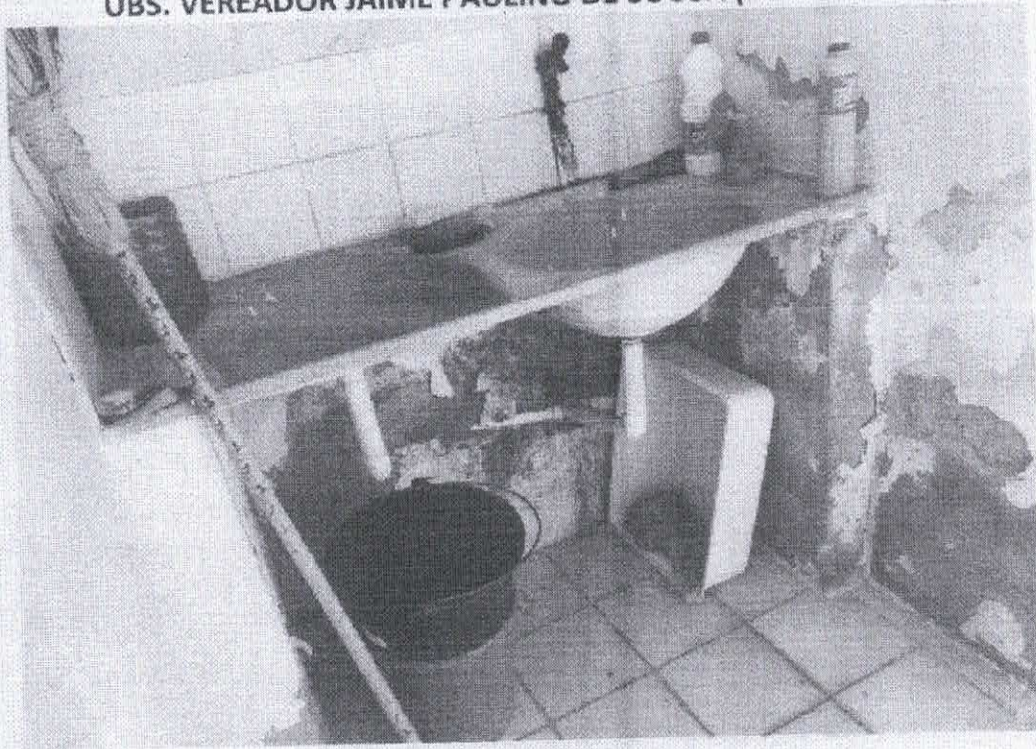
Figura 7 – REVESTIMENTO DANIFICADO
