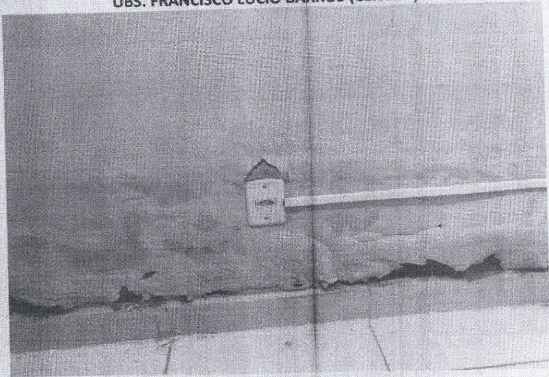
Figura 7 - REVESTIMENTO DANIFICADO
