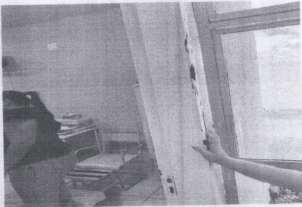
Figura 6 – FORRAMENTO DANIFICADO
