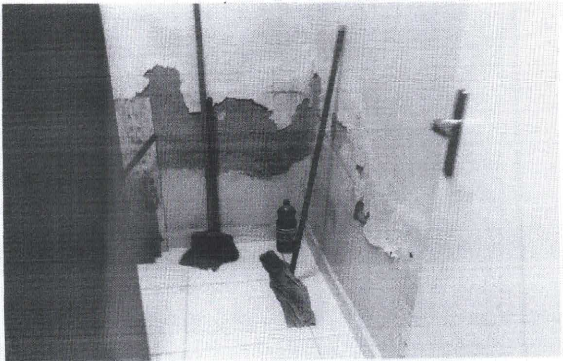
Figura 8 - REVESTIMENTO DANIFICADO
