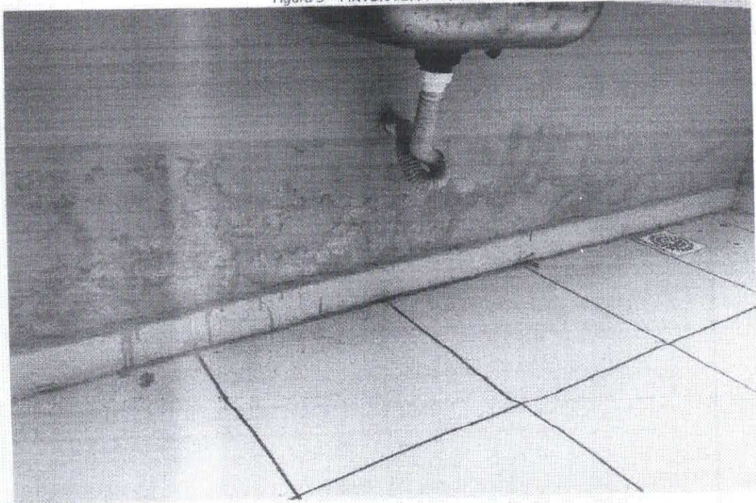
Figura 6 – REVESTIMENTO DANIFICADO
