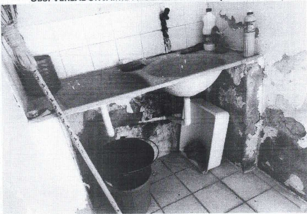
Figura 7 – REVESTIMENTO DANIFICADO
