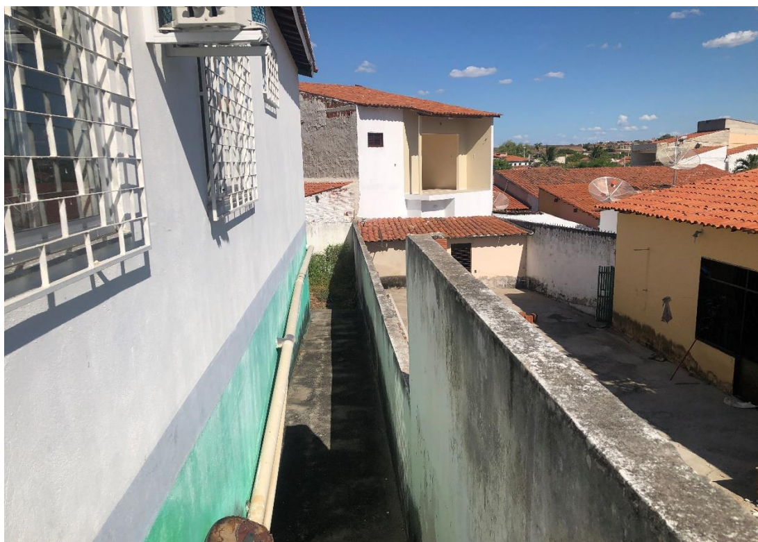
Figura 4 – FACHADA LATERAL – DIFERENÇA MURO DE PROTEÇÃO
