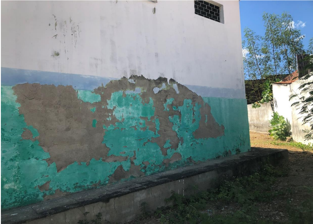
Figura 5 – PINTURA DANIFICADA
