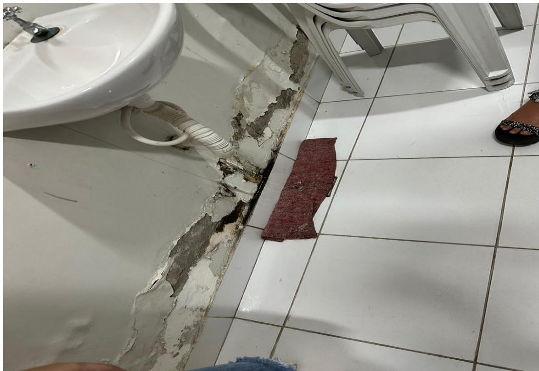
Figura 8 – REVESTIMENTO DANIFICADO
