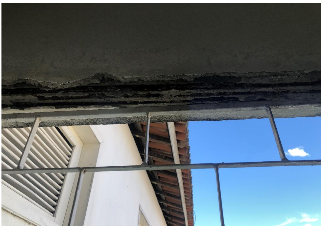
Figura 8 – FERRAGEM EXPOSTA
