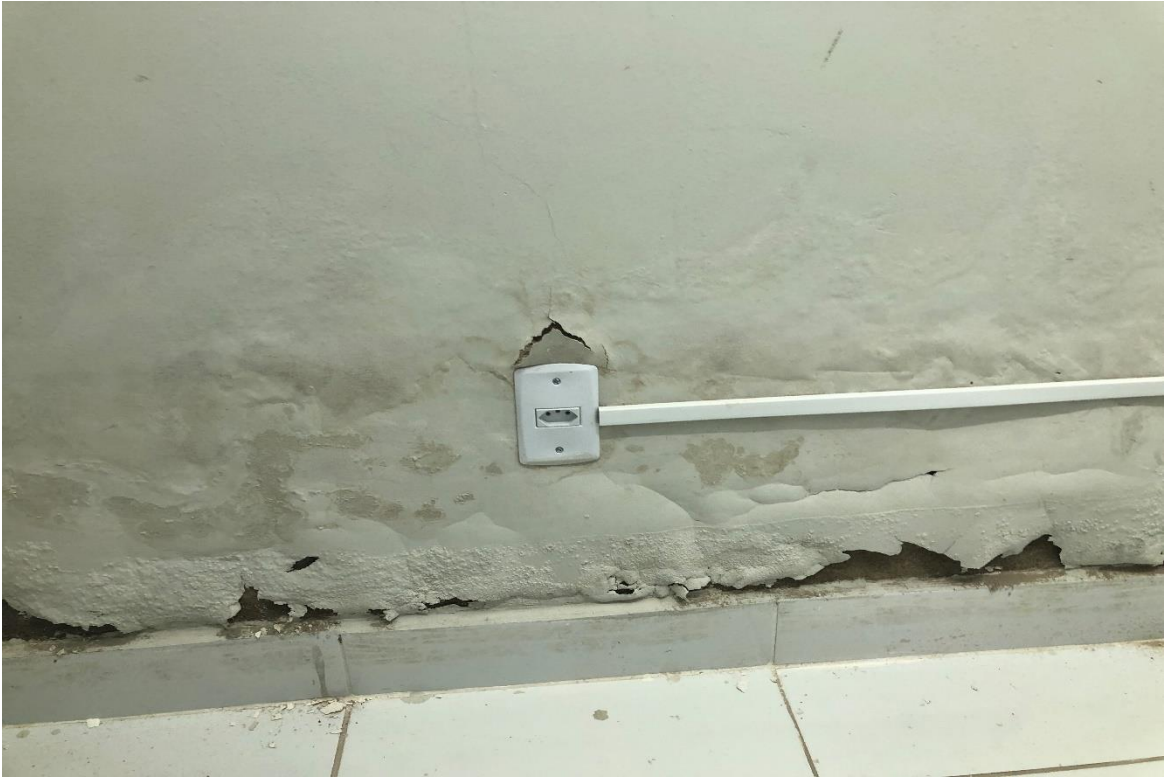
Figura 7 – REVESTIMENRO DANIFICADO
