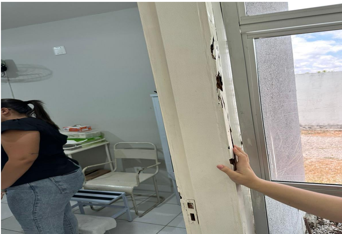
Figura 6 – FORRAMENTO DANIFICADO
