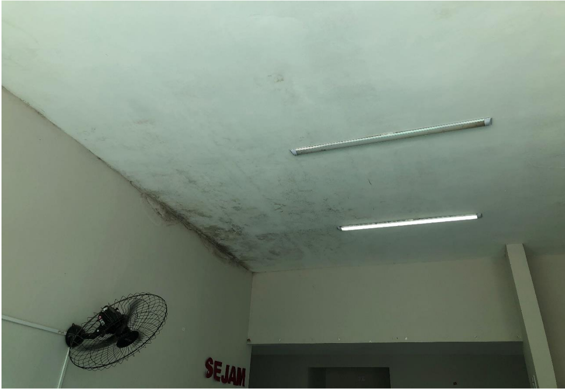
Figura 5 – PINTURA DANIFICADA
