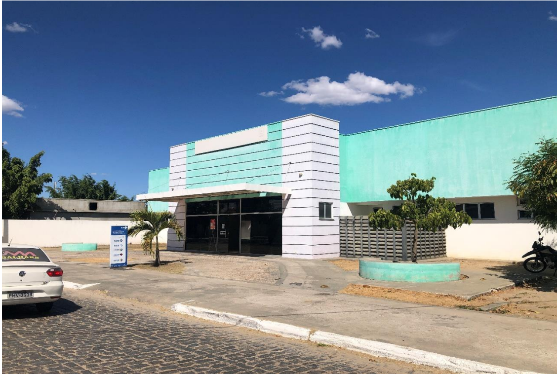
Figura 1 – FACHADA FRONTAL E CALÇADA
