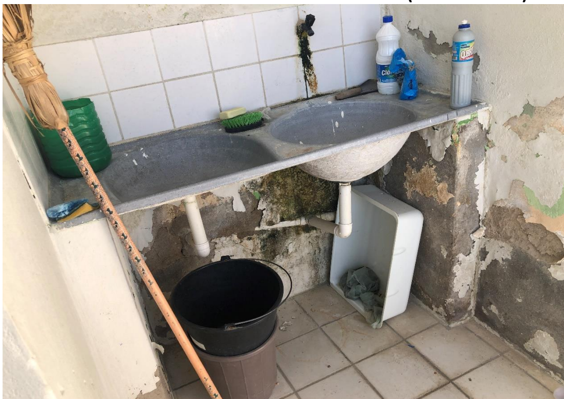
Figura 7 – REVESTIMENTO DANIFICADO
