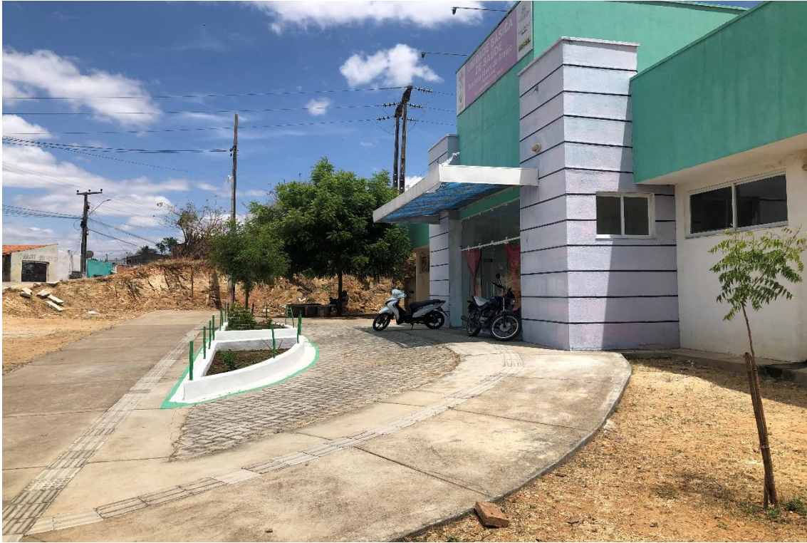
Figura 1 – FACHADA FRONTAL E CALÇADA
