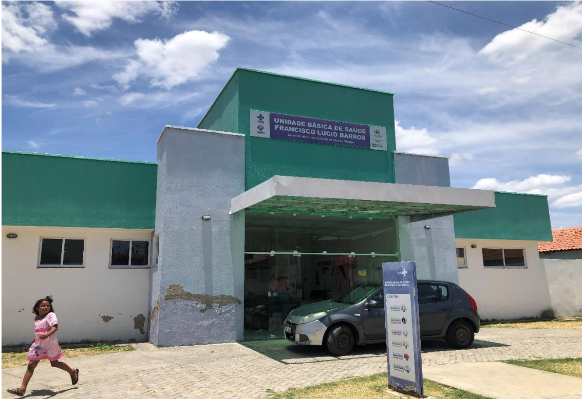
Figura 1 – FACHADA FRONTAL E CALÇADA
