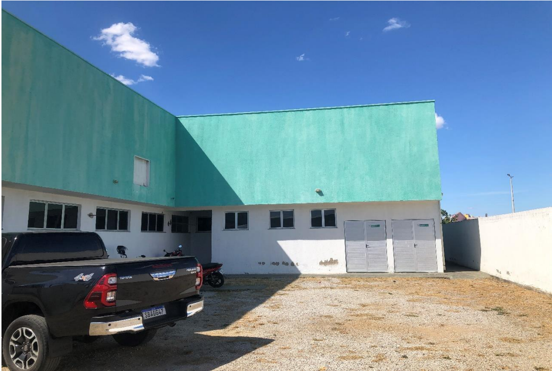
Figura 3 – FACHADA – LATERAL / FUNDOS
