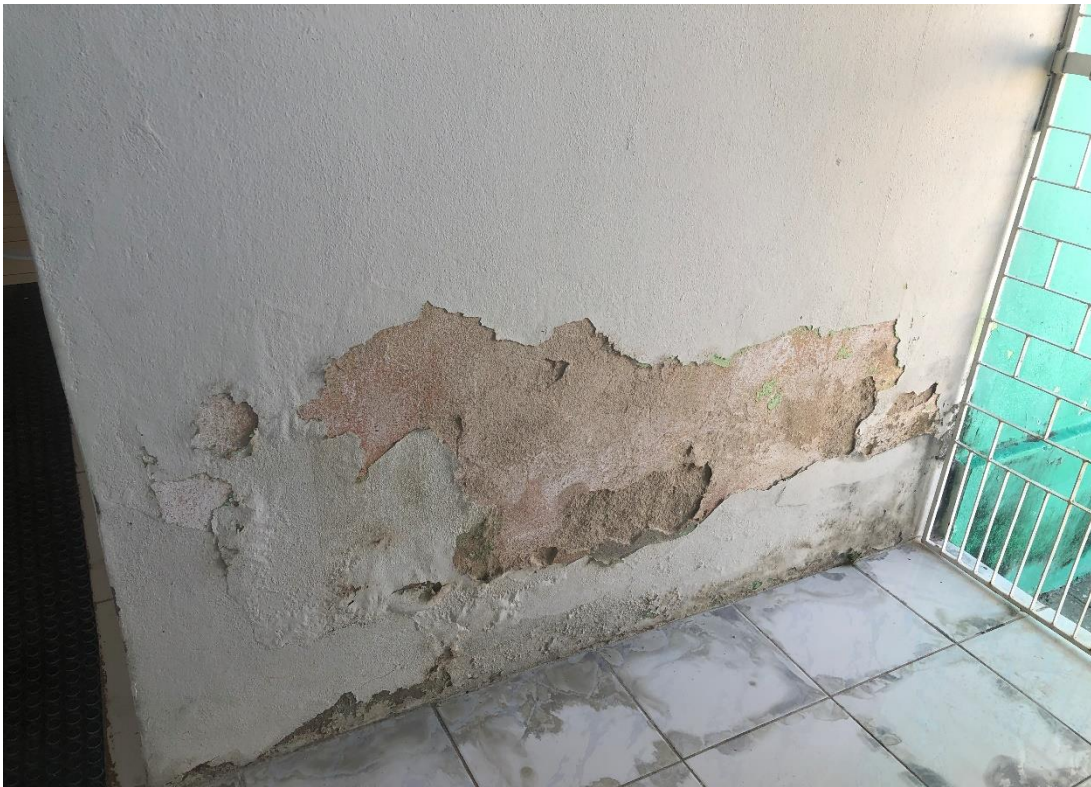
Figura6 – REVESTIMENTO DANIFICADO
