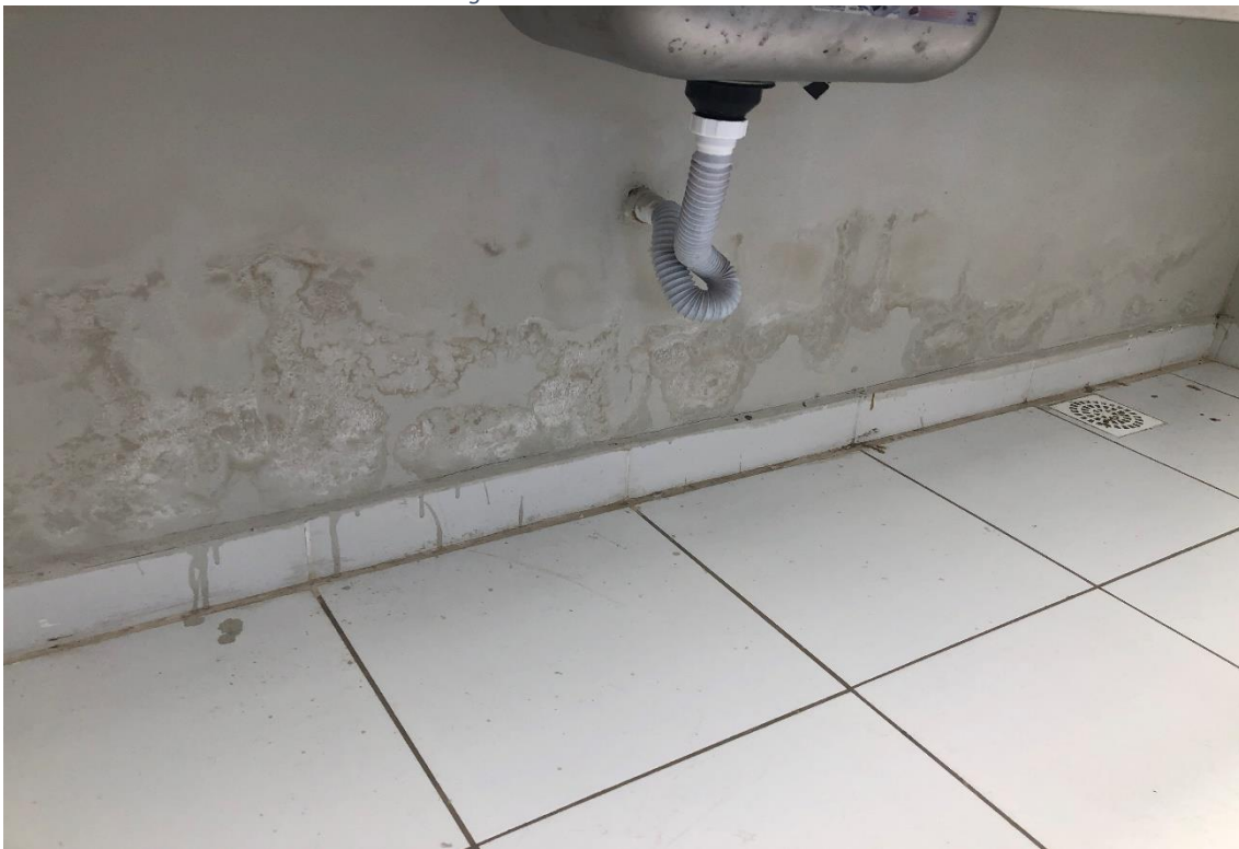
Figura 6 – REVESTIMENTO DANIFICADO
