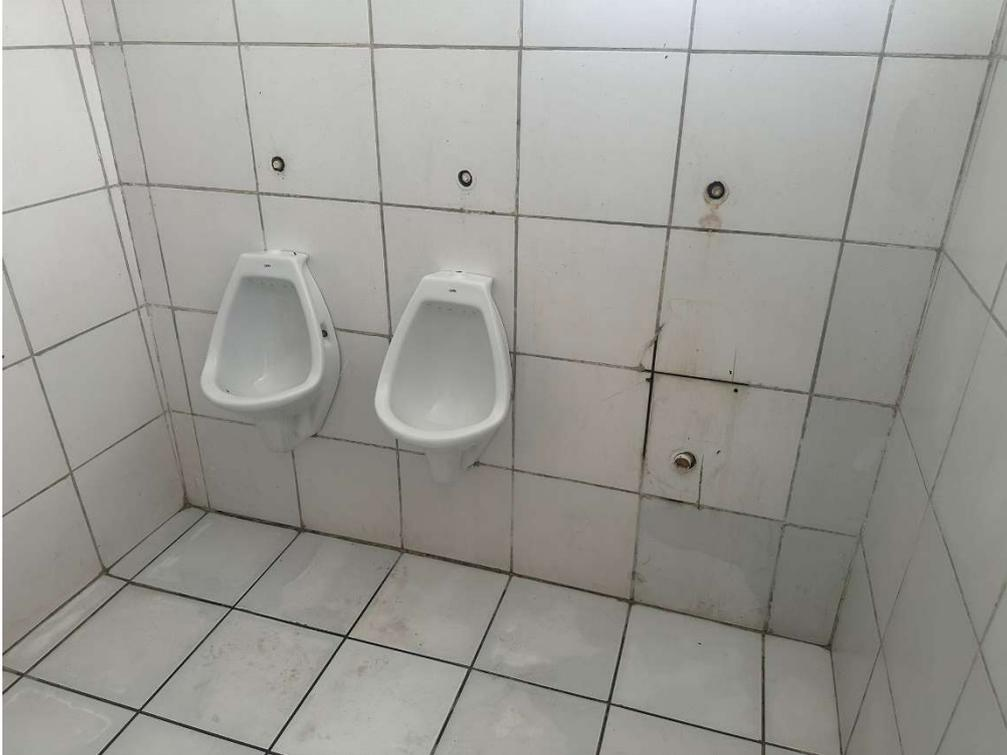
*Figura 3 – BANHEIRO MASCULINO SEM DIVISÓRIA E MICTÓRIOS SEM FUNCIONAMENTO*
